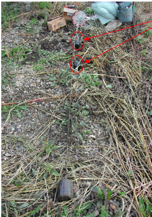
交換後のレベルセンサー全景
