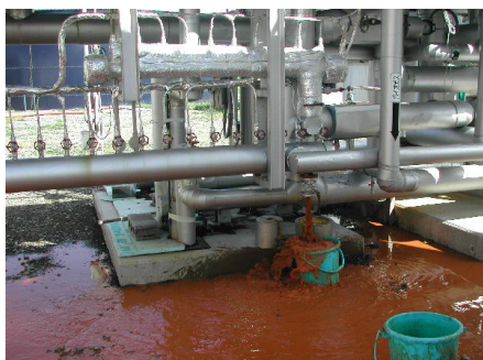
図3 管路洗浄状況
