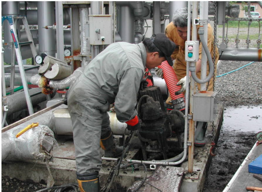
ポンプメンテナンス状況
