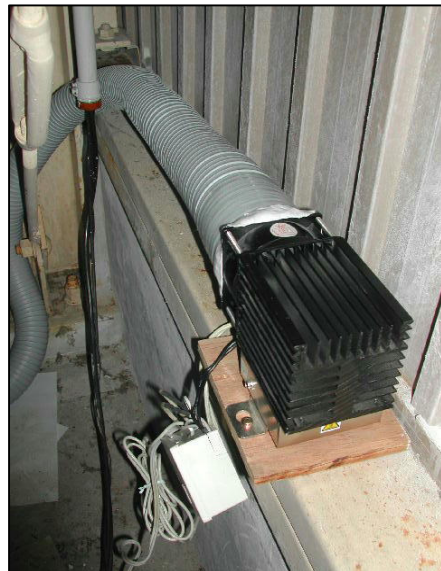
左の制御盤の中にシーケンサーカードが格納されている 制御室内に屋外の空気を送るファン(新設)
