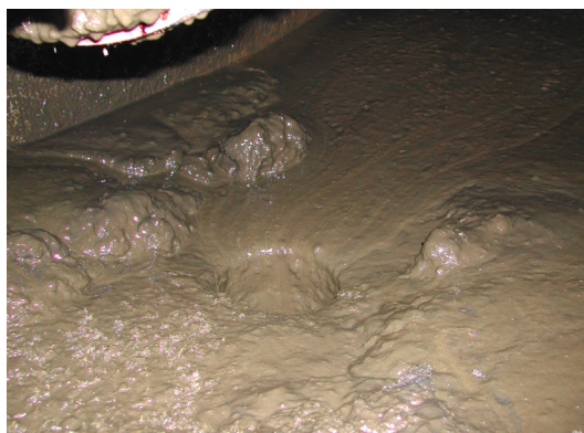
正常な液分回収ホースへの入口
