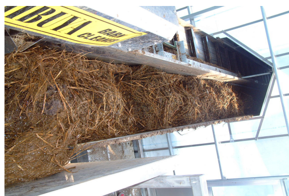
定量送り込み装置からふん尿を搬送するバンクリナー
