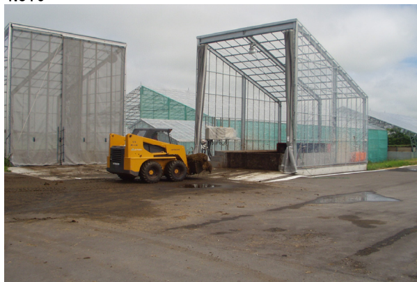
定量送り込み装置が設置された受入ハウス
