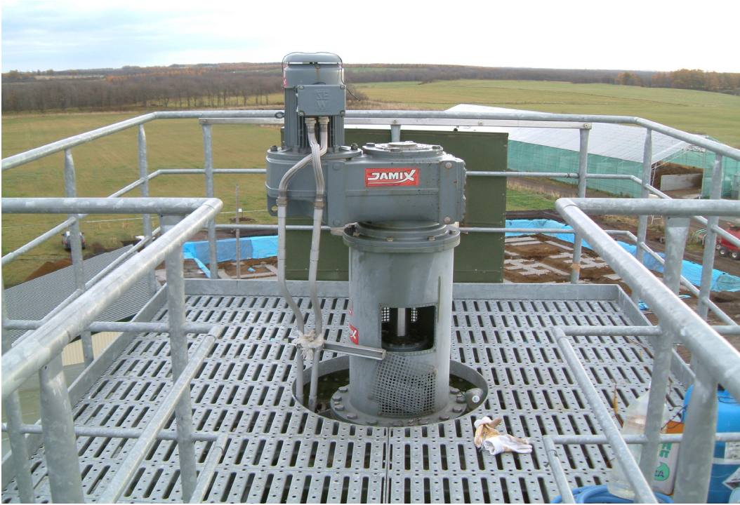
攪拌機全景。左上にモーターがあり、中央上部のギアボックスで回転数を落とすとともにトルクを得る。
