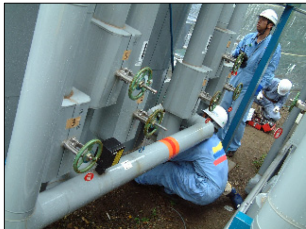
上写真：乾式脱硫塔の裏側の配管とバルブ群 左写真：乾式脱硫塔正面写真 下写真：閉塞していたバルブ。イオウは除去した後。
