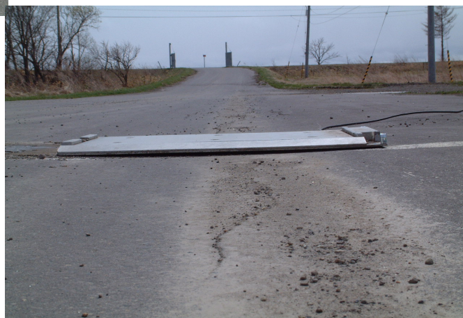
下写真：轍部は計量板が浮いた状態になっている 車輛が通過するたびに搦み、計器の故障を助長すると同時に、秤量精度にも影響する。
