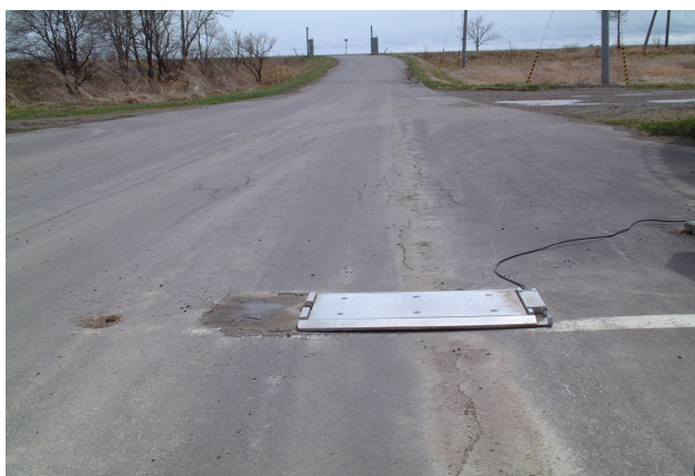
上写真：平成13年度当初の状況 左写真：轍が掘れている様子
