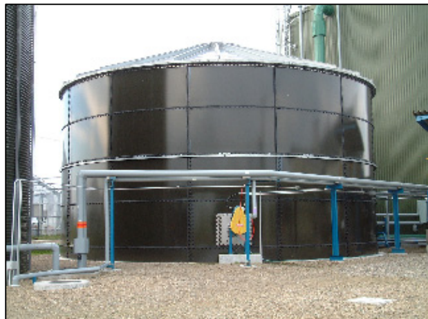
ガス流出口を移設する前の状況
