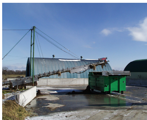
写真1 コンテナの設置状況
