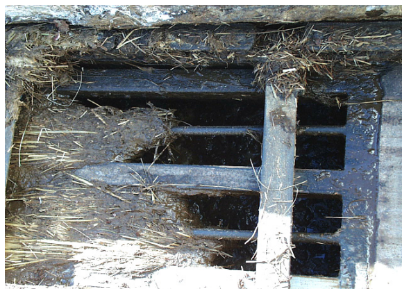
写真-24 糞尿回収バーン内のスリット
