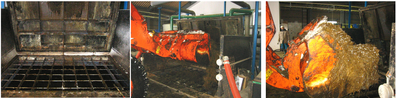
写真-15・16・17 分離固分投入状況
