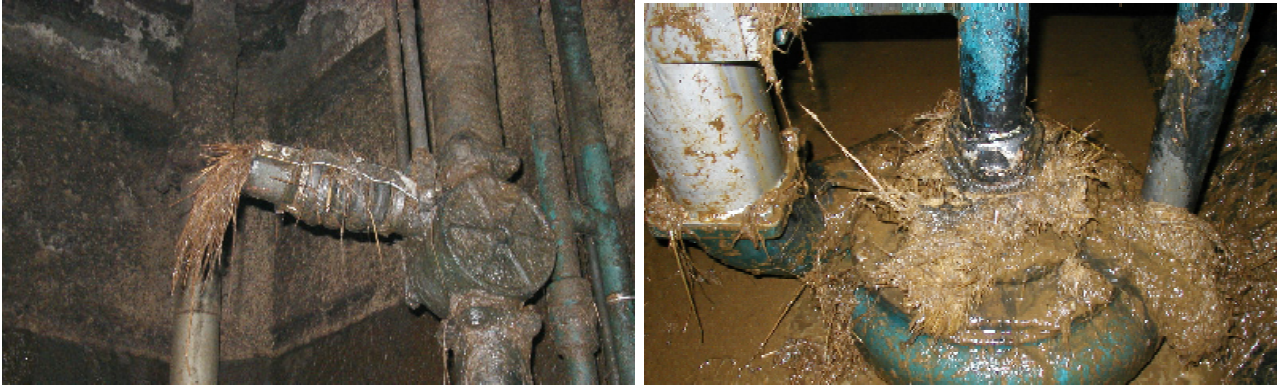
写真-11 敷料混合ふん尿の直接投入による破砕ポンプでの閉塞状況 左：攪拌水流の吐出口の閉塞 右：破砕用マセレータ部の閉塞
