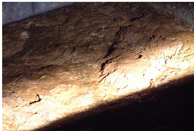
写真－3 2002年11月20日予備攪拌前の状況
