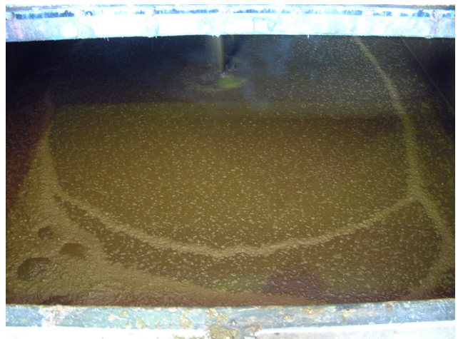
写真－10 2002年11月22日モノポンプ破碎の状況
