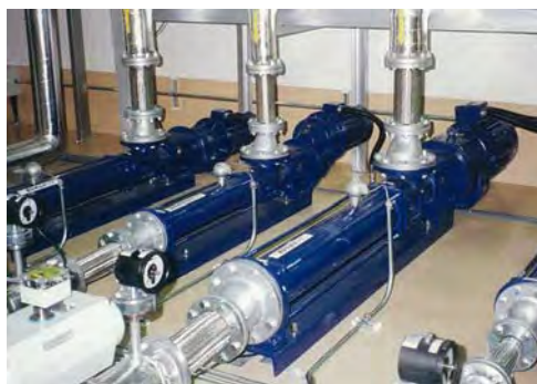
写真 4-2-3 圧送スラリーポンプ
