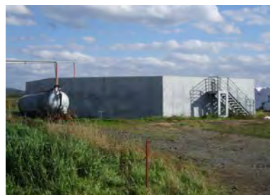
写真 1-2-7 コンクリート槽
