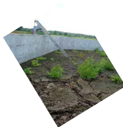
写真 5-2-1 配水調整槽におけるスカムの発生状況
