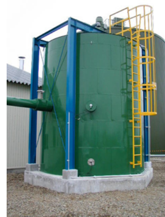
写真 1-5-3 殺菌槽の例(別海施設)
