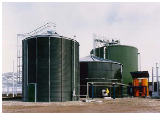
写真 1-5-2 発酵槽(右)・ガスホルダー(中央・左) 脱硫塔(右端赤)の例(別海施設)
