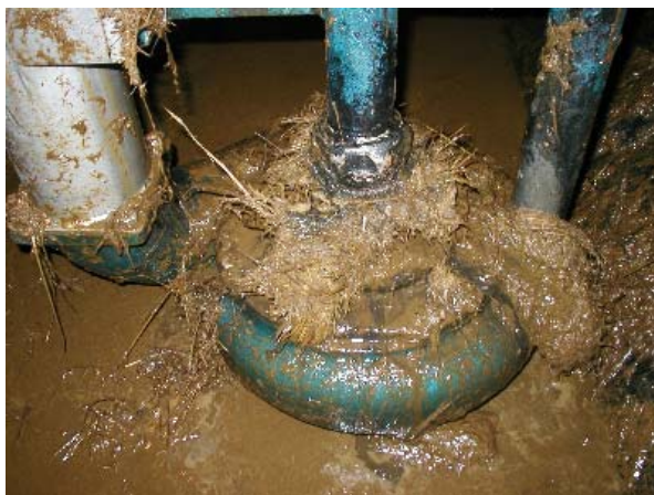
写真 3-6-3 破砕ポンプの破砕用マセレータ部の閉塞
