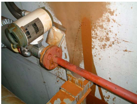
写真4-9-1 温水配管の腐食状況
