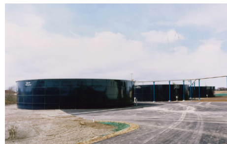
写真 1-5-4 消化液貯留槽の例(別海施設)
