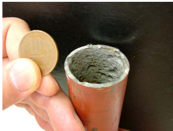
写真4-9-2 配管内部の孔食状況 (SGP32A)
