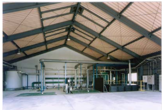
写真 1-5-1 受入設備の例(別海施設)
