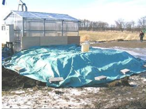
写真 3-6-1 スラリー凍結防止のためのピット上屋と断熱のための盛土 5)
