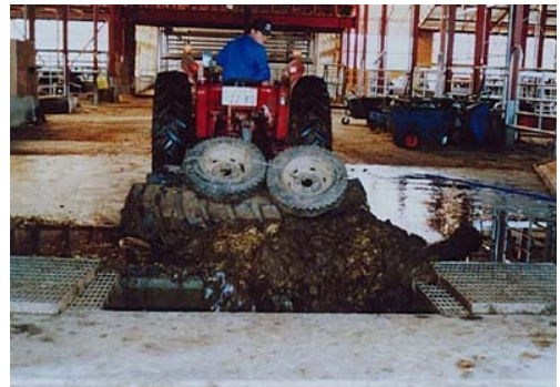
写真4-2-1 フリーストール牛舎の一時貯留槽
