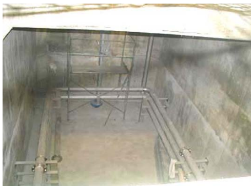
写真4-4-2 受入槽内部の消化液配管の例
