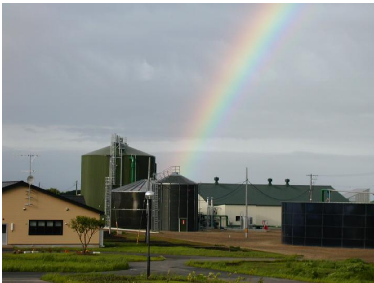
資源循環別海施設
