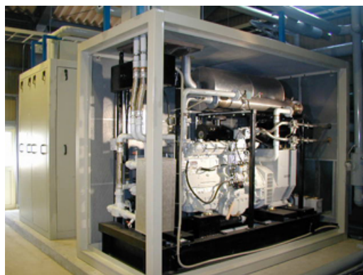
写真 1-5-5 コージェネレータの例 出力65kW(別海施設)
