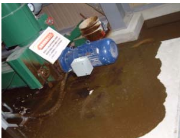
写真4-9-3 モーノポンプの液漏れの例
